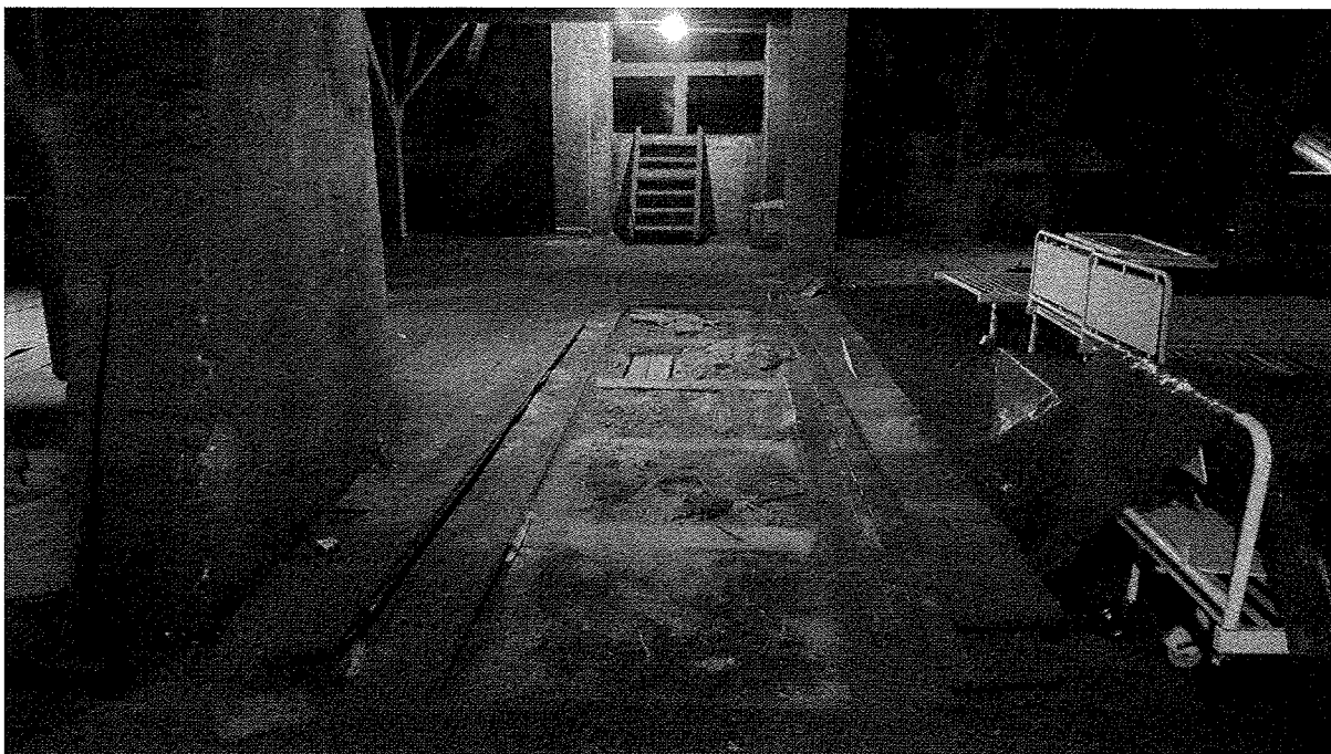
Poddasze budynek główny miejsce wykonania odkrywki.
