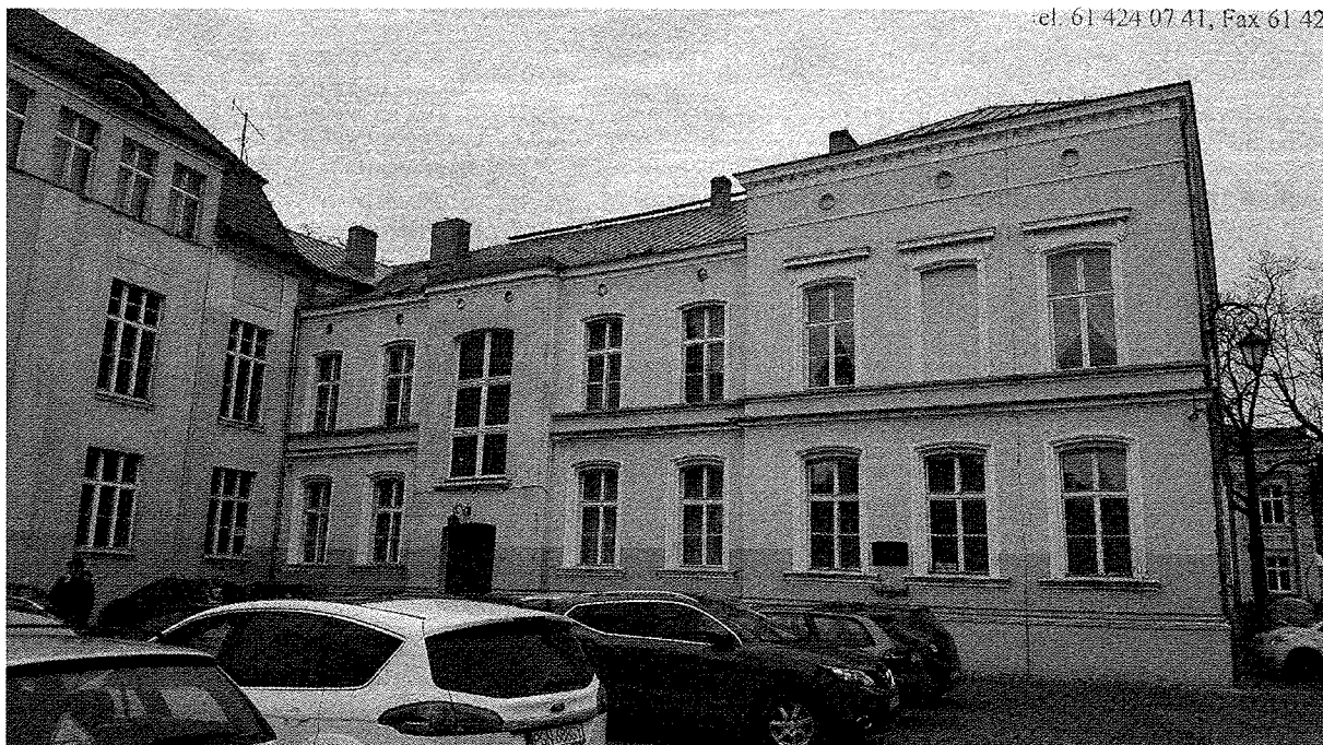
Budynek główny – dziedziniec szkolny.
