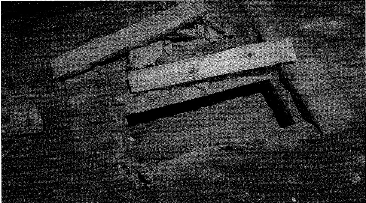
Odkrywka podłogi – budynek główny.
