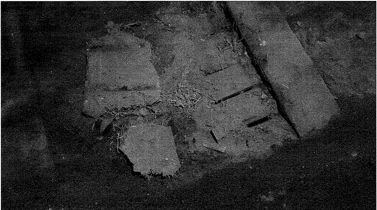
Odkrywka podłogi – budynek główny.
