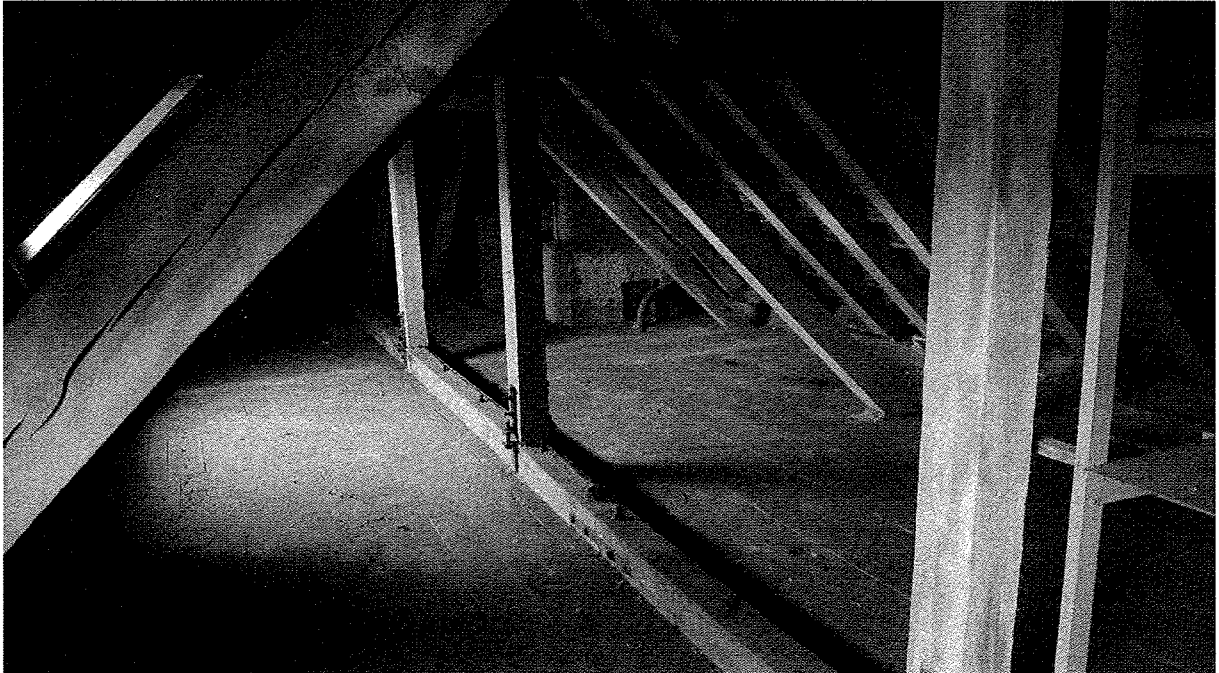
Poddasze – dobudowane skrzydło, dach mansardowy.
